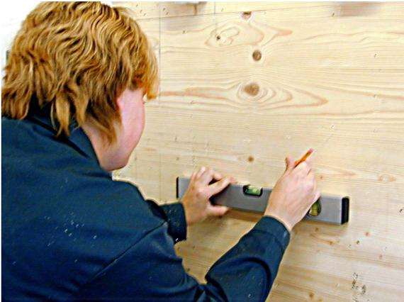
On trace un emplacement d'un appareil en dessinant une croix à l'aide d'un niveau et d'un crayon à papier ou d'une craie.
