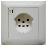
La prise type 15 offre l'avantage d'avoir dans la même prise 1x 230 et 3 x 400 V. Elle est alimentée par 5 fils soit : 3LNPE. Elle supporte 10 A.
