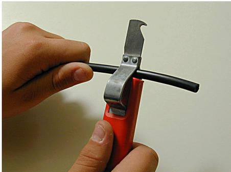
On dénude le cordon TD ou GD à l'aide d'un dénude-câble en faisant attention de ne pas abîmer les conducteurs.
